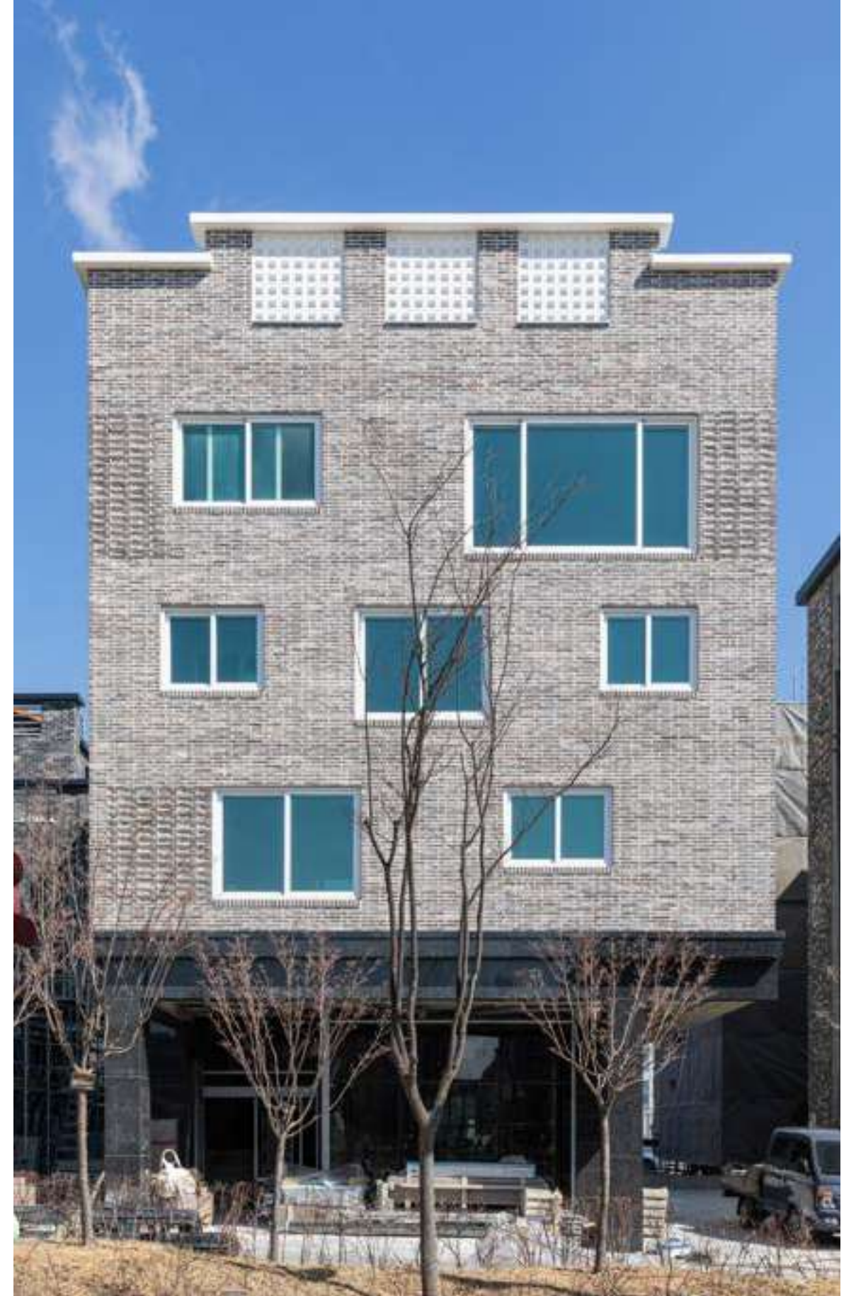
230 앤틱청고, 흰색줄눈 오송, 공동주택
